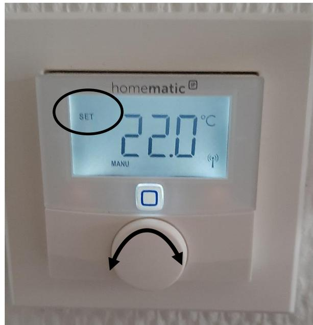
In der Anzeige erscheint zusätzlich SET oben links und Sie können die gewünschte Temperatur einstellen. Wenn Sie ein paar Sekunden keine Veränderung vornehmen, wird die neue gewünschte Temperatur an die Steuerzentrale übermittelt und die Heizung schaltet sich ggf. ein oder aus und es wird diese Temperatur (+/- 0,4 Grad) gehalten.
